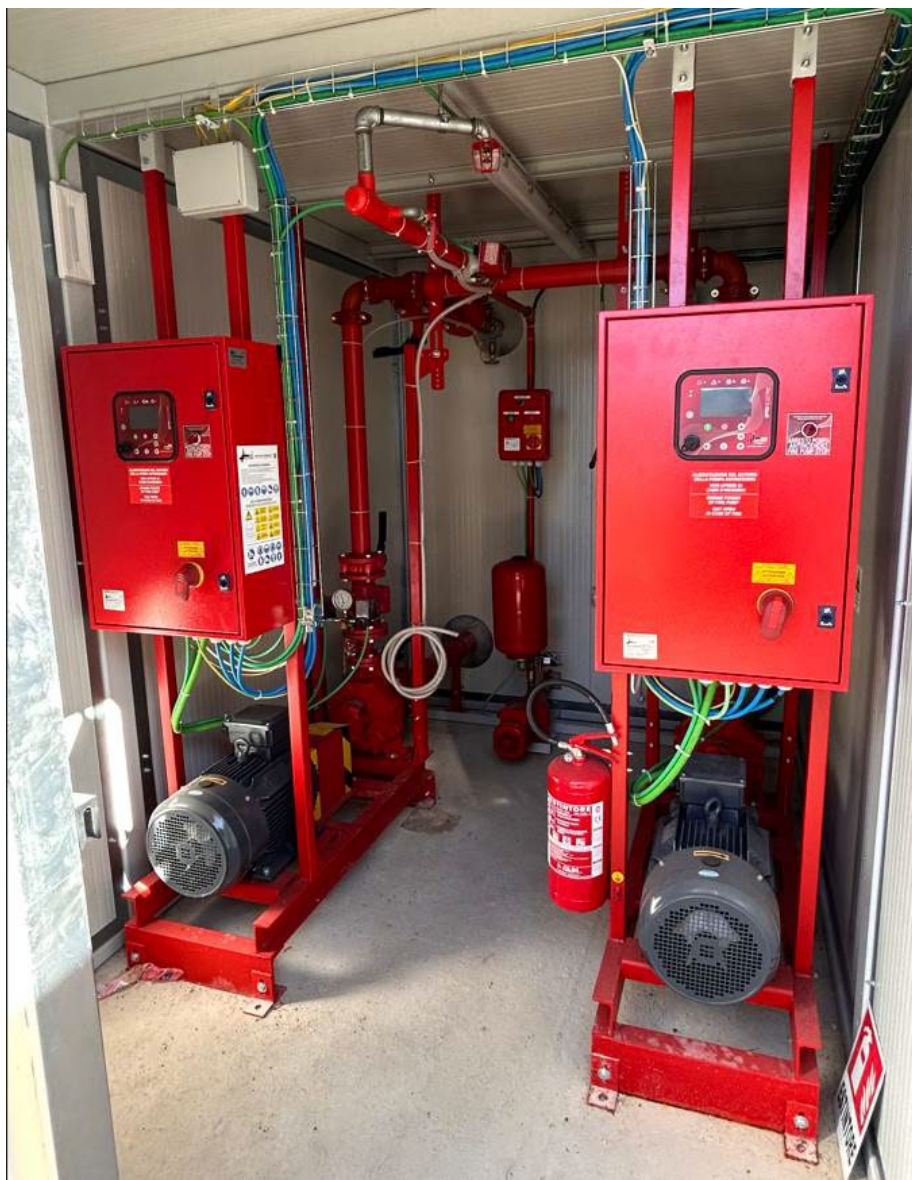
Doppia elettropompa esistente
